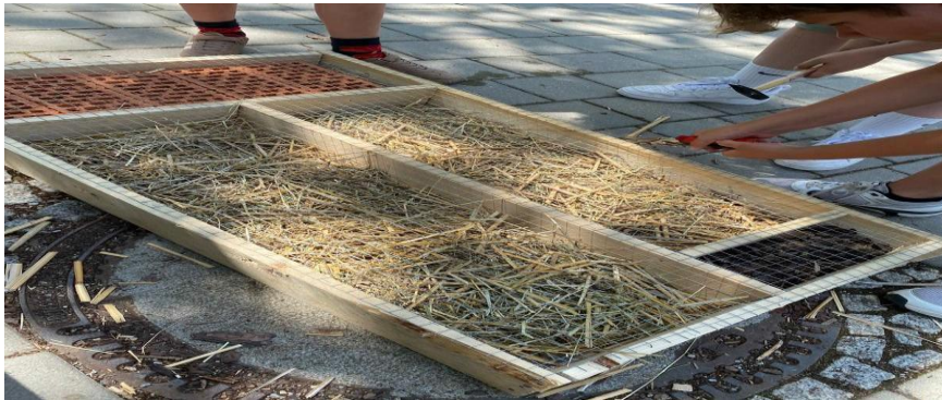
Ein Drahtgitter sichert die Füllung
